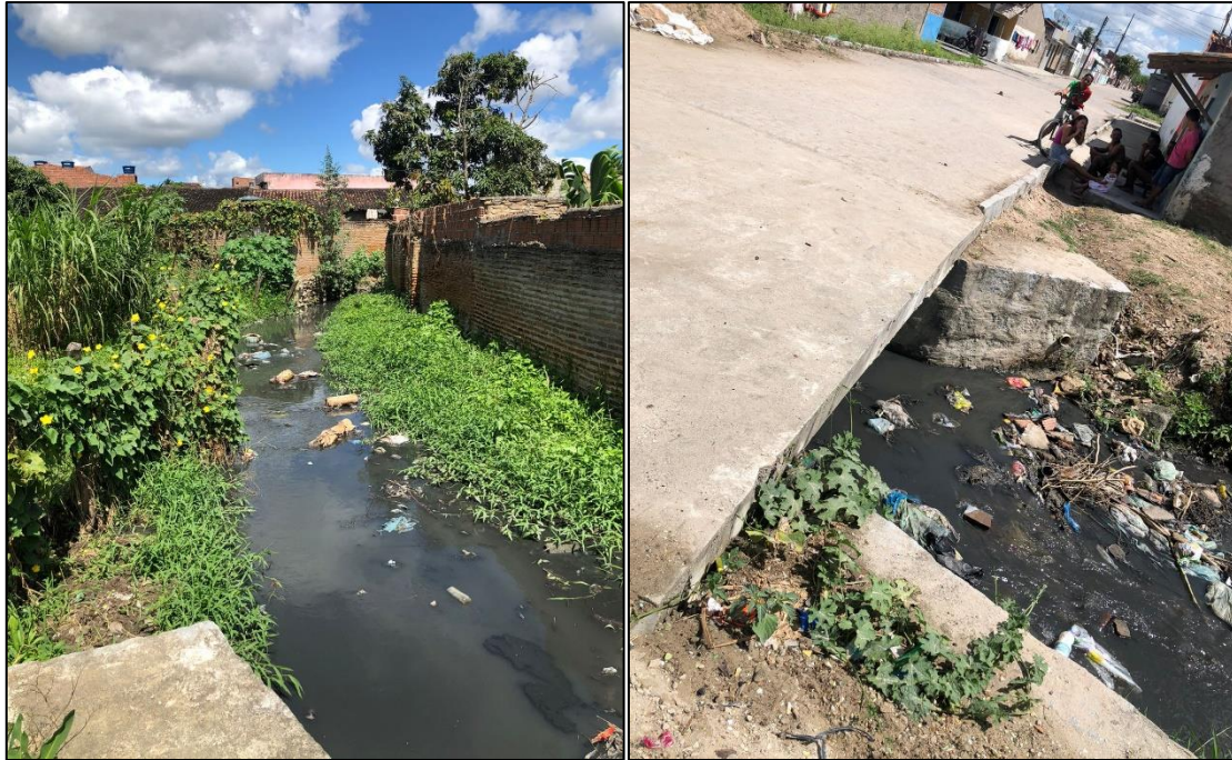
Figura 24 – Esgoto a céu aberto em Altinho.
