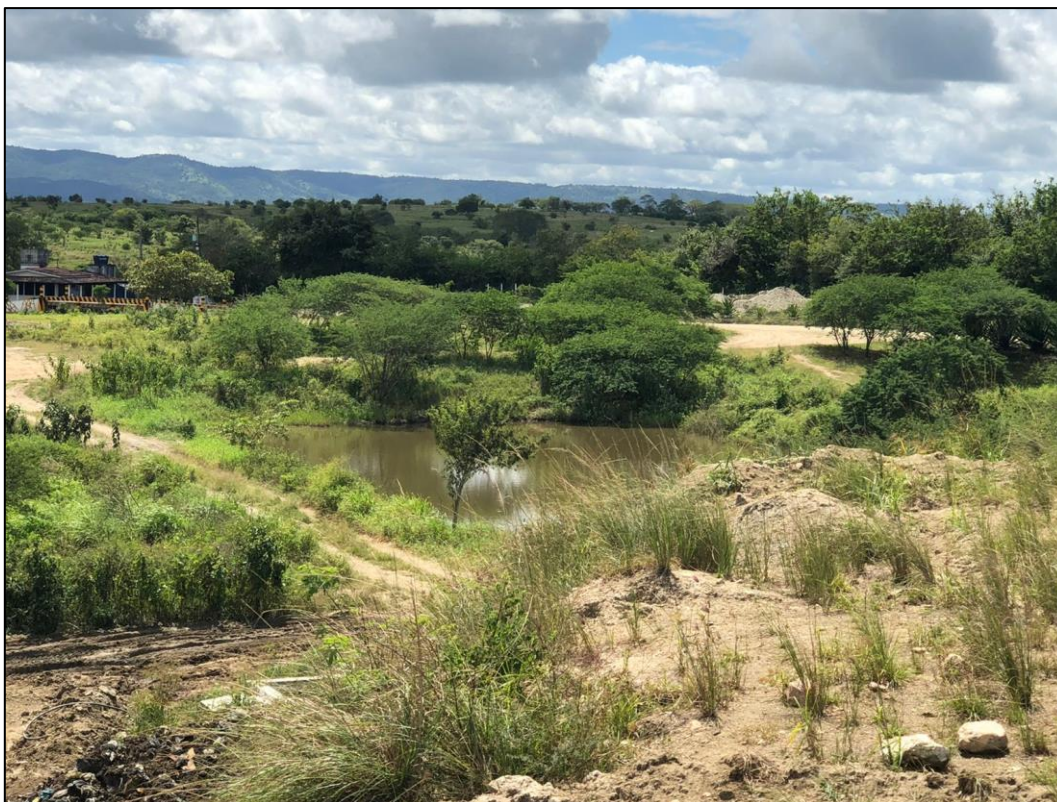
Figura 76 – Lagoa de tratamento de chorume.
