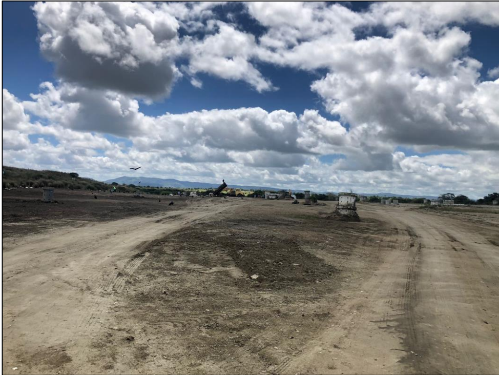
Figura 74 – Aterro sanitário de Altinho.
