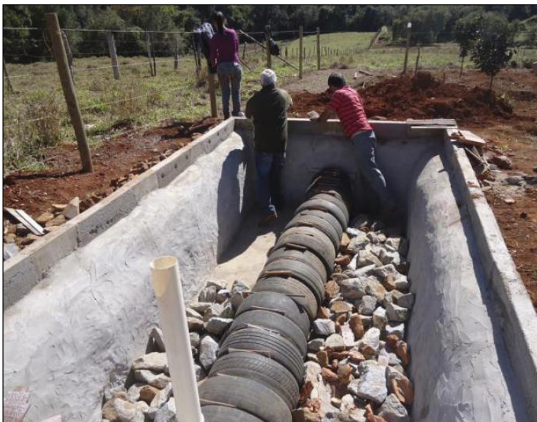
Figura 104 – Construção de círculo de bananeira.
