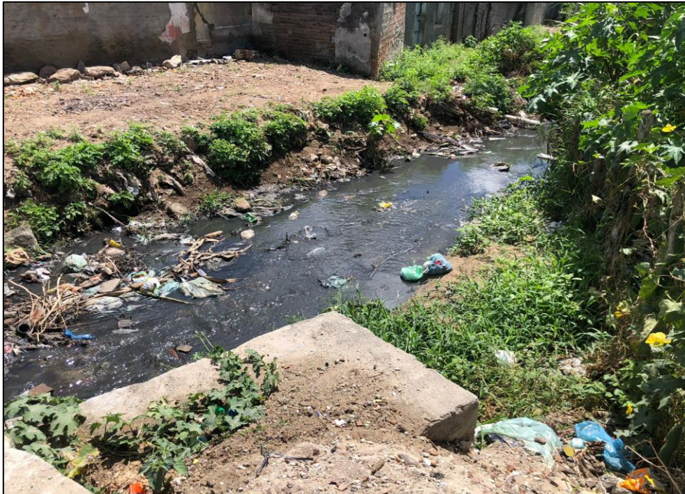
Figura 25 – Esgoto a céu aberto em Altinho.
