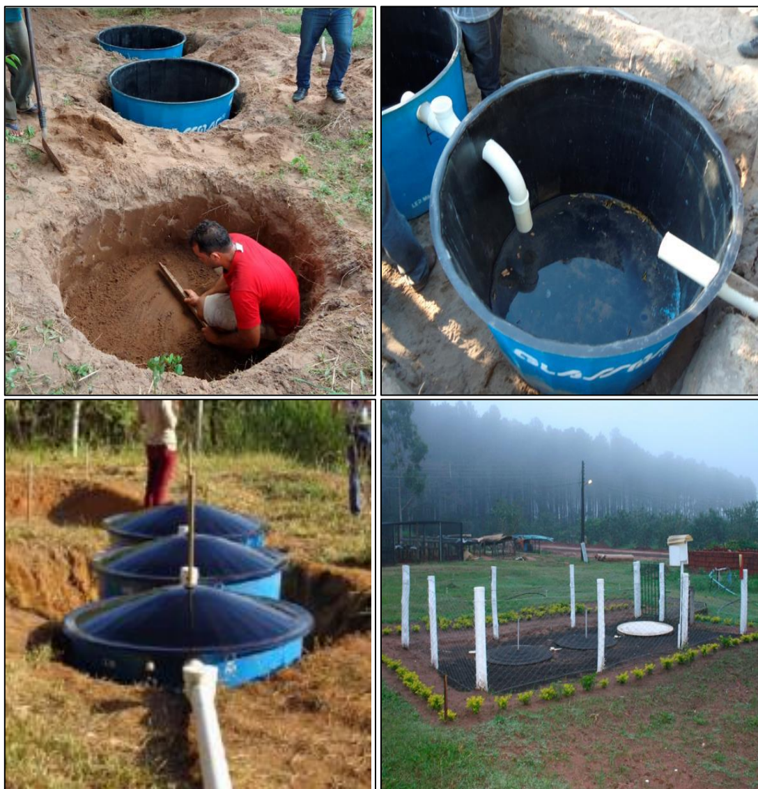
Figura 96 – Esquema da fossa séptica biodigestora.
