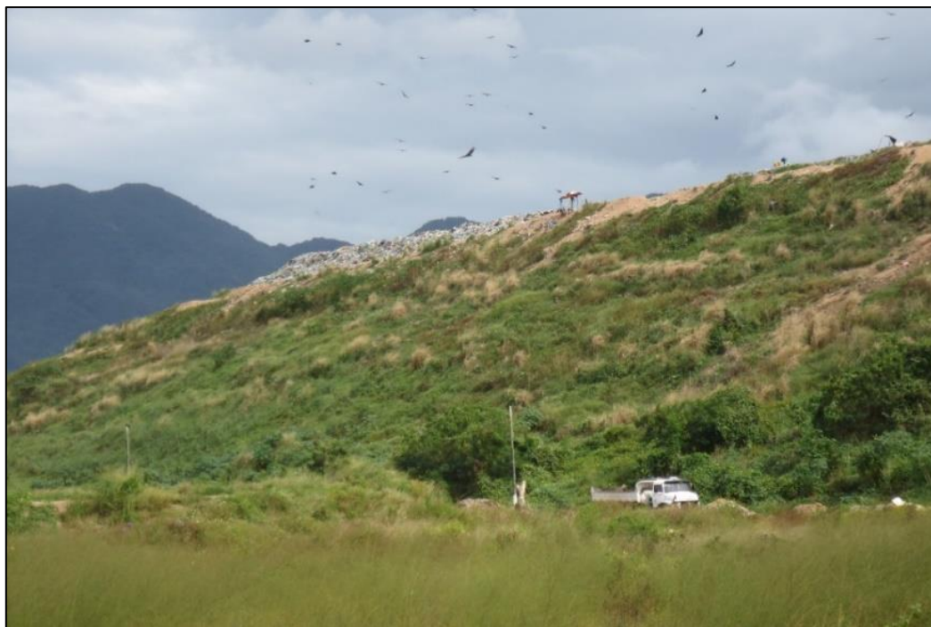
Figura 55 – Exemplo de aterro controlado.
