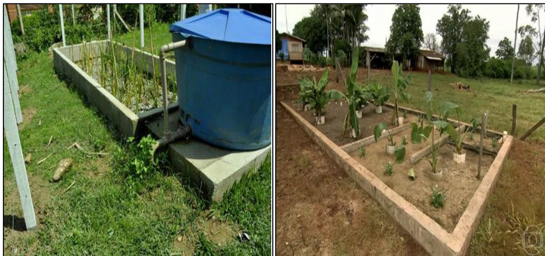
Figura 98 – Esquema de zona de raízes ou SAC.
