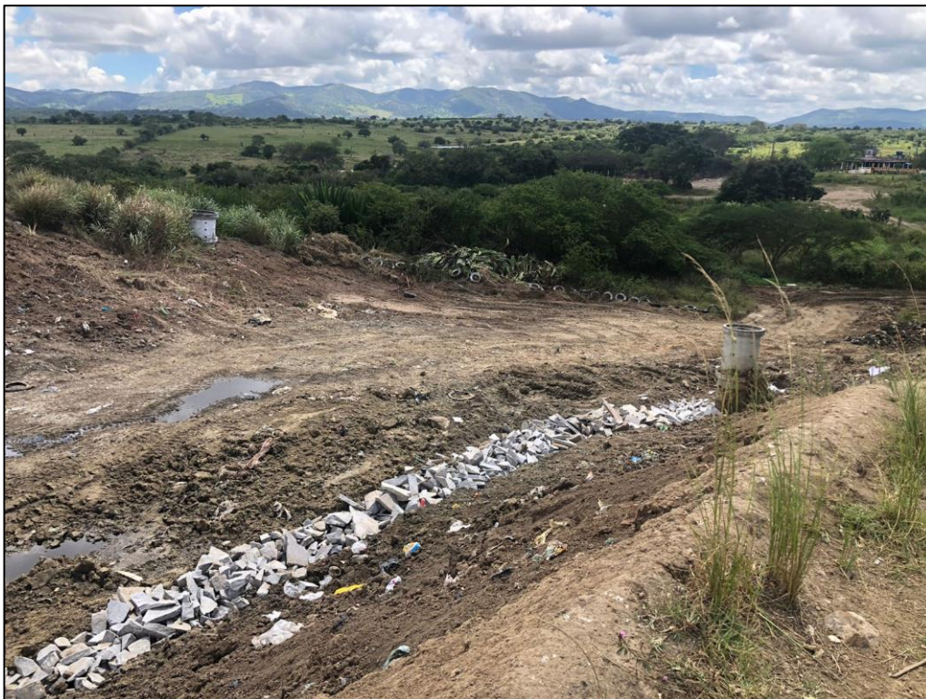
Figura 73 – Aterro sanitário de Altinho.
