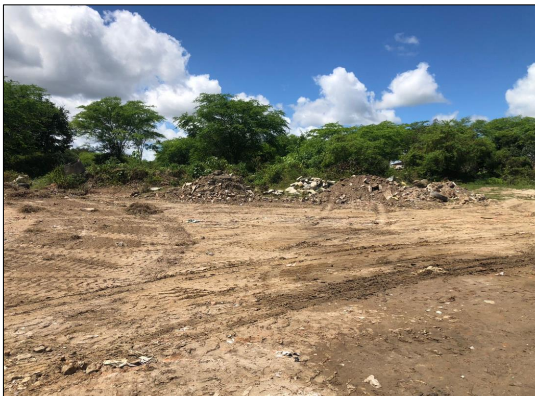
Figura 53 – Descarte e acúmulo de RCC.
